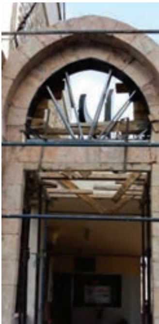
في مرحلة إعادة البناء
